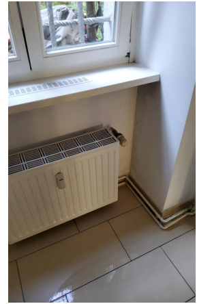
Foto: Heizkörper / Fensterbereich
